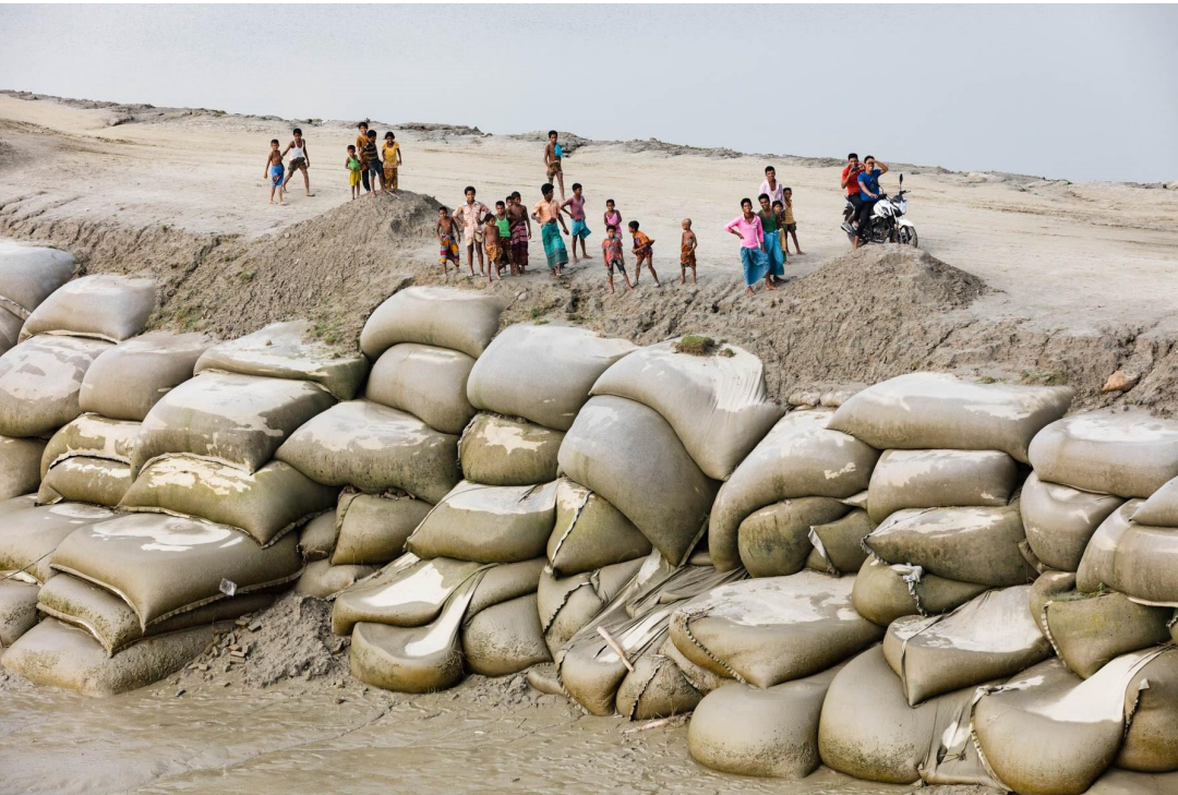
Barrage édifié en sacs de sable sur le delta du Gange au Bangladesh pour contrer la montée des eaux (Chittagong District). Si l'on ne parvient pas à réduire nos émissions de gaz à effet de serre, de nombreux territoires seront recouverts par les océans.
