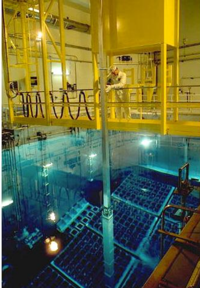
Déchargement de combustible sous eau dans la centrale nucléaire de Golfech (Tarn-et-Garonne) © EDF
