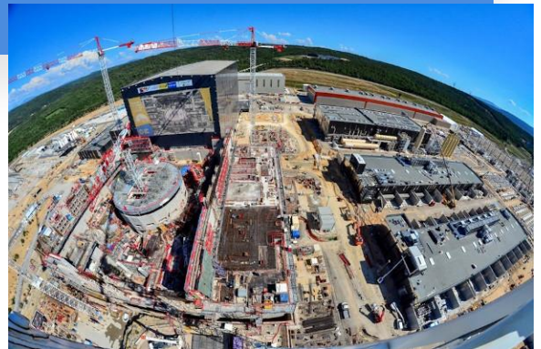
Vue panoramique du chantier ITER en 2018 © ITER
