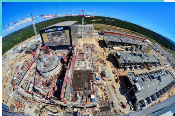
Vue panoramique du chantier ITER en 2018 © ITER
