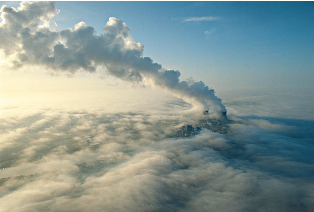
Centrale nucléaire de Saint-Laurent-des-Eaux dans le Loir-et-Cher (France) © Yann Arthus-Bertrand
