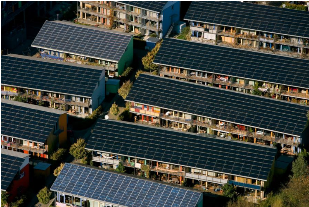
Immeubles couverts de panneaux solaires dans l'éco-quartier Vauban de Freiburg (Allemagne) © Yann Arthus-Bertrand
