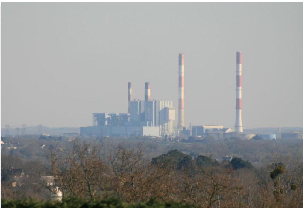
La centrale électrique de Cordemais (Loire-Atlantique) fonctionne au charbon © WikiMedia Commons
